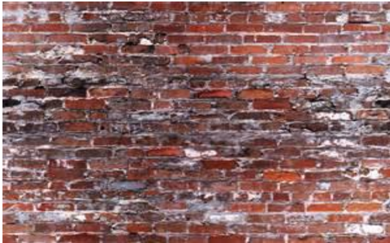
اشکل- د ټيټ او خراب کيفيت لرونکو خاورو خښتې او د ښورې څرگنديدل.
